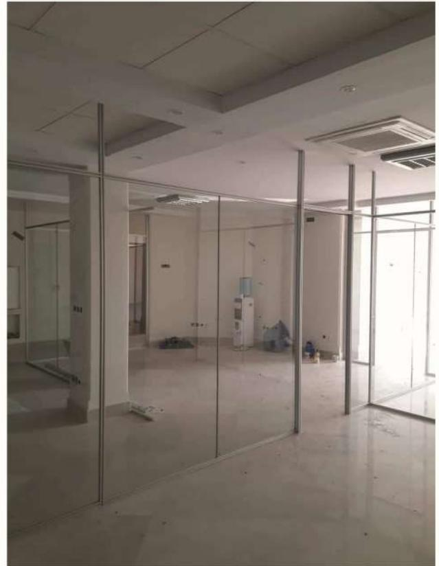
در حال حاضر ساخت پارتیشن با پروفیل های آلومینیوم مخصوص پارتیشن بسیار متداول می باشد. طرح های بسیار زیبا و متنوعی هم در بازار عرضه می گردد اما گاهی اوقات به منظور کاهش هزینه می توان از پروفیل های آلومینیوم شیاردار استفاده کرد و از مهمترین مزایای آن امکان اجرای آن توسط خود کاربر می باشد و از این رو چیزی که مد نظر کاربر هست ساخته می شود
